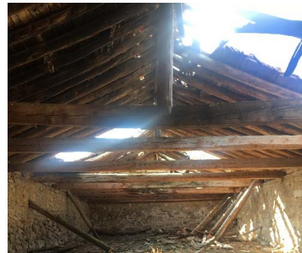
Imagen del Interior de la Edificación 01
